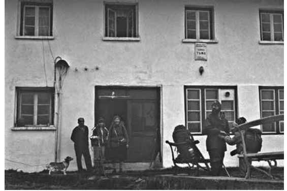
Eingang der Tashahütte
